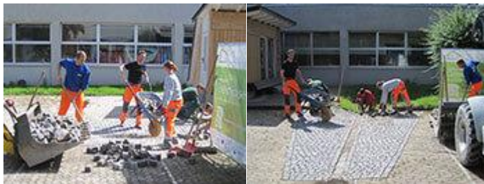
Abbildung 10: Eine Zufahrt wird gepflastert, © GreenHouse
