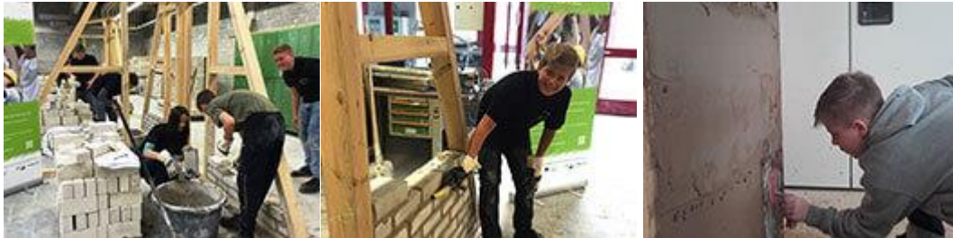
Abbildung 7: Innenwände werden erstellt, © GreenHouse
