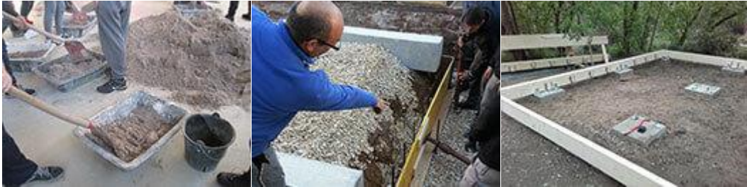
Abbildung 4: Arbeiten an der Gründung, © GreenHouse
